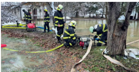
Čerpání vody při havárii hlavního vodovodního řádu ve Slušovicích (foto: ag)
